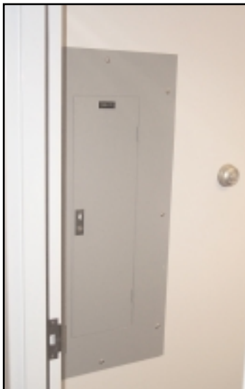
3-1 277 Volt Panel Office #
